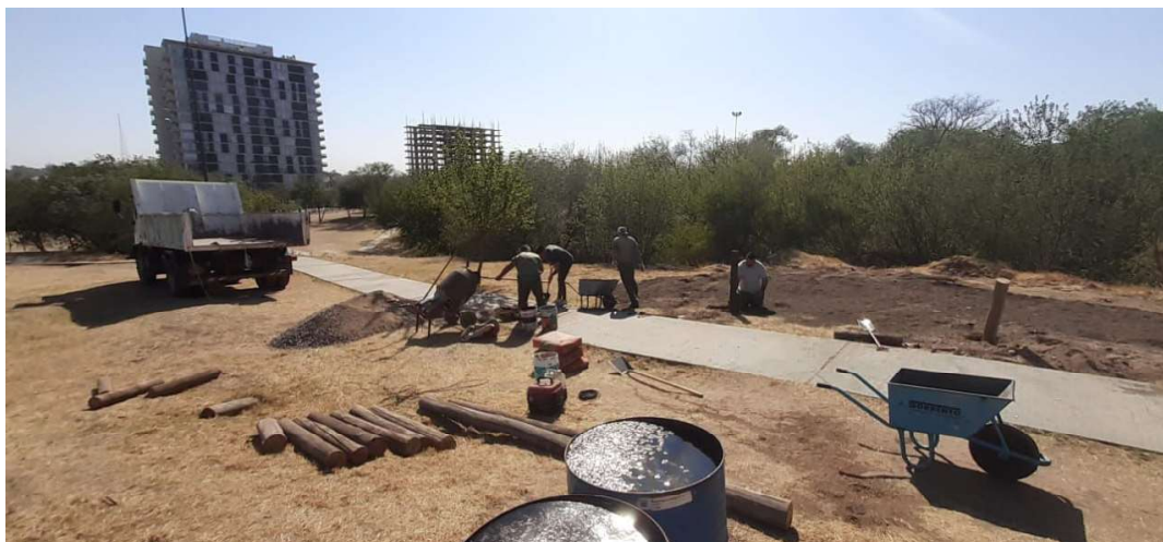
Imagen 7. Construcción del perímetro del jardín. Se puede observar la tierra negra extendida.
